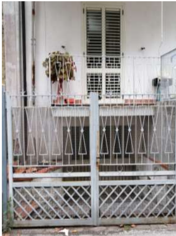
FOTO 08 - Ingresso strada Deposito
